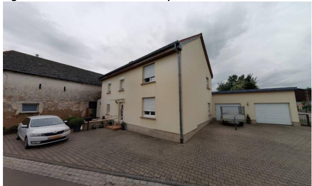
Figure 6: Vue sur la construction en question
