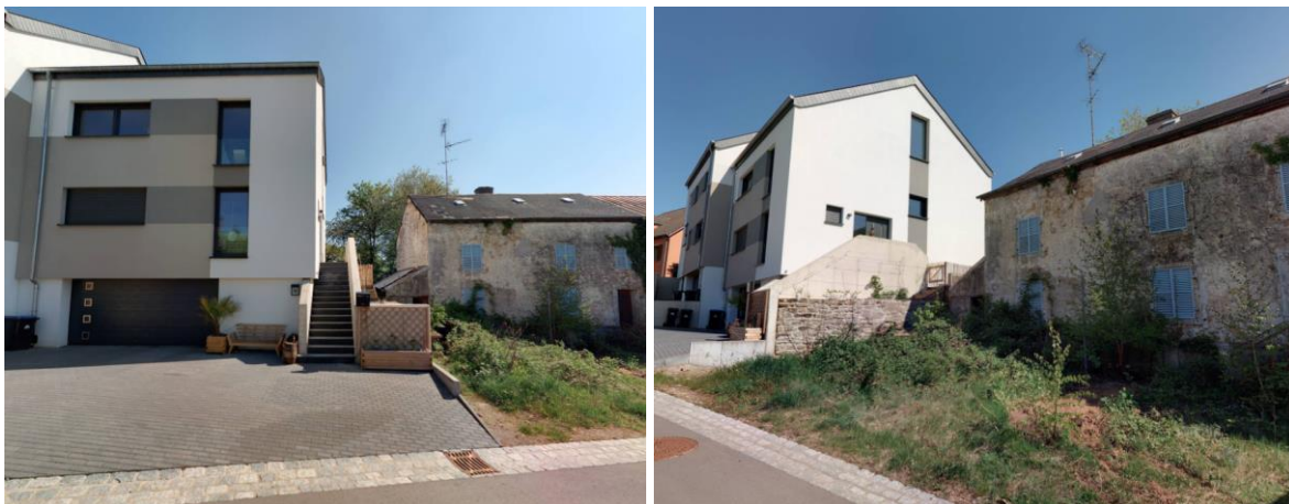
Figure 10 : Comparaison entre la construction en question et la maison voisine
